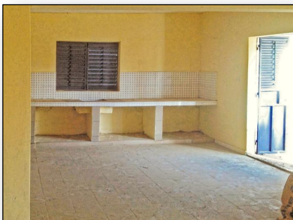
Rénovation complète du local du groupement des femmes
