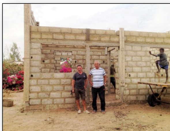
Construction de l'extension de la case de santé
